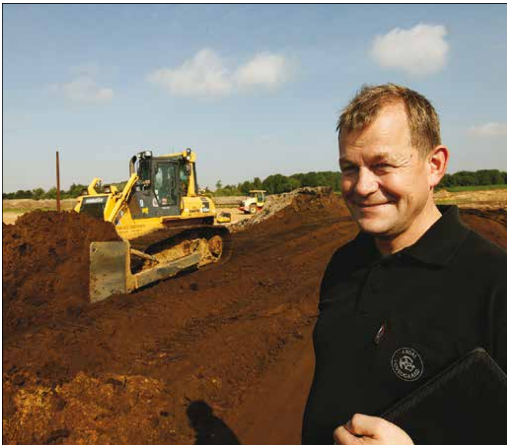
GrønGas Vrå ejes og drives i partnerskab af E.ON Danmark og Jens Peter Lunden, som her ses på byggepladsen. Foto: Axel Søgaard.
